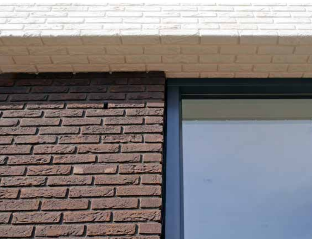
Aansluitdetail metselwerk en gevelstrips.
